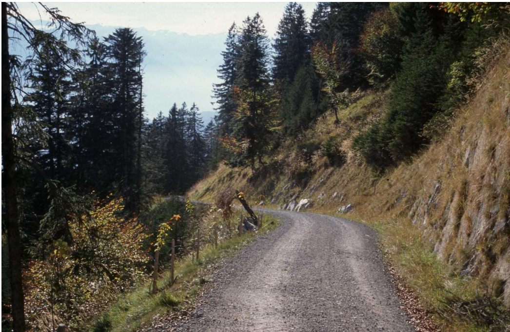
Bild 9: Thaur – technisch und landschaftlich gelungener Forstwegbau im schwierigen Gelände
