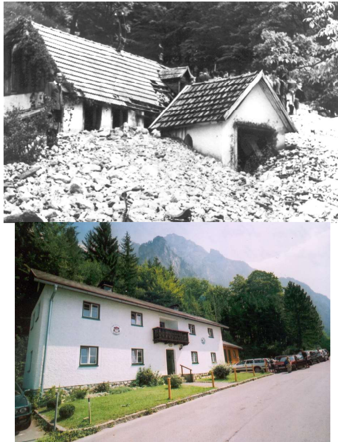
Abb. 7a, 7b: Während eines Unwetters im Juli 1955 verwüstete ein Schuttgang aus dem Lenzlgraben das Lias'n Haus. Ein an dieser Stelle neu errichtetes Wohnhaus dient heute dem Bergrettungsdienst (Foto 7a: Hannes Loderbauer 1955; 7b: J. T. Weidinger 2003).
