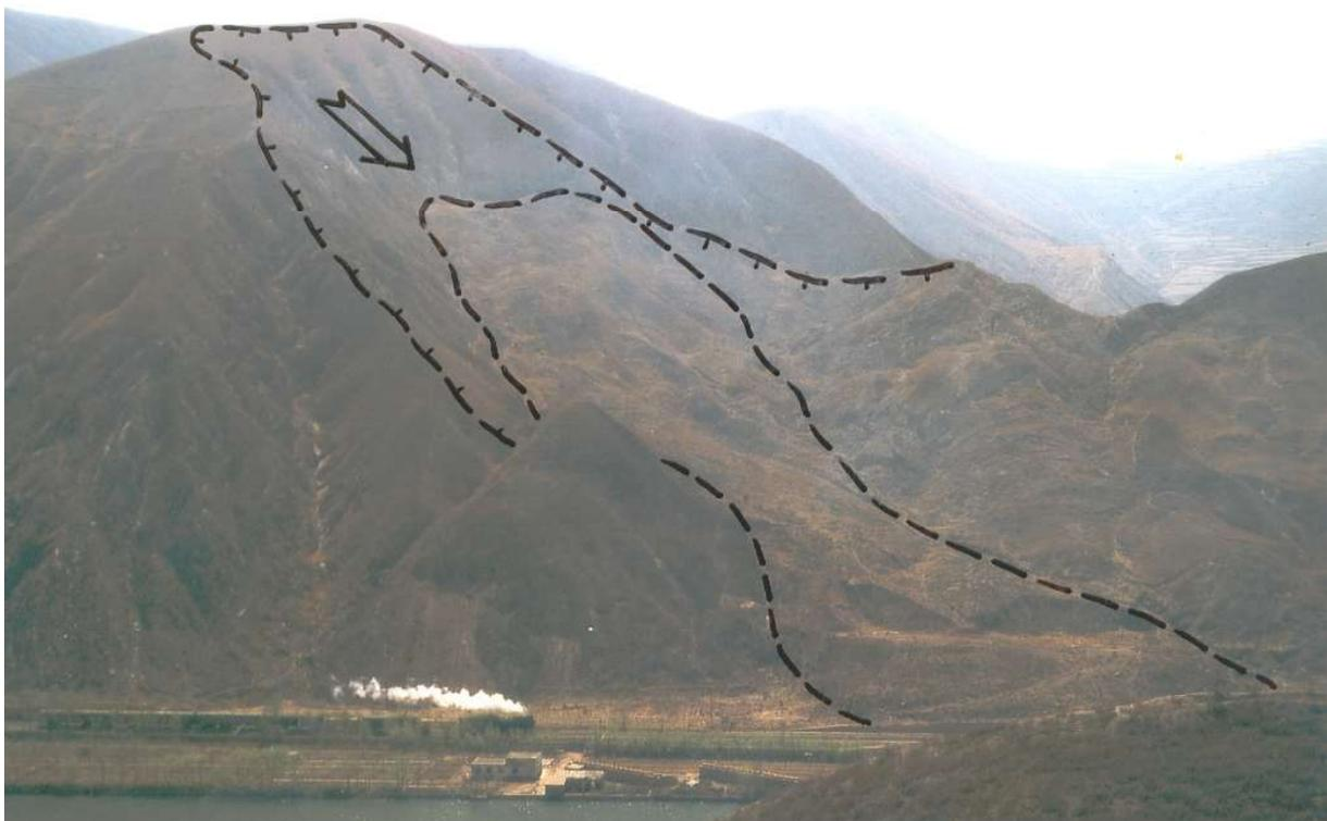
Abb. 8: Rutschbereich im Löss hinter dem Ta Pan Xia- Damm westlich von Lanzhou, dessen Akkumulationsbereich die Eisenbahnstrecke von Lanzhou nach Xining (geplant bis Lhasa) vernichtete (Foto: J. Weidinger, 1997).
