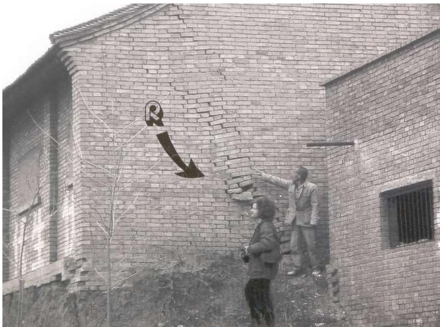
Abb. 2: Subsidenzerscheinungen im Löss durch intensive landwirtschaftliche Bewässerung und Niederschläge sind eines der Hauptprobleme der Bevölkerung; Risse im Mauerwerk der Häuser (R) von Wen Tia Po nahe Lantian durch Setzungen im Löss (Foto: J. Weidinger, 1997).
