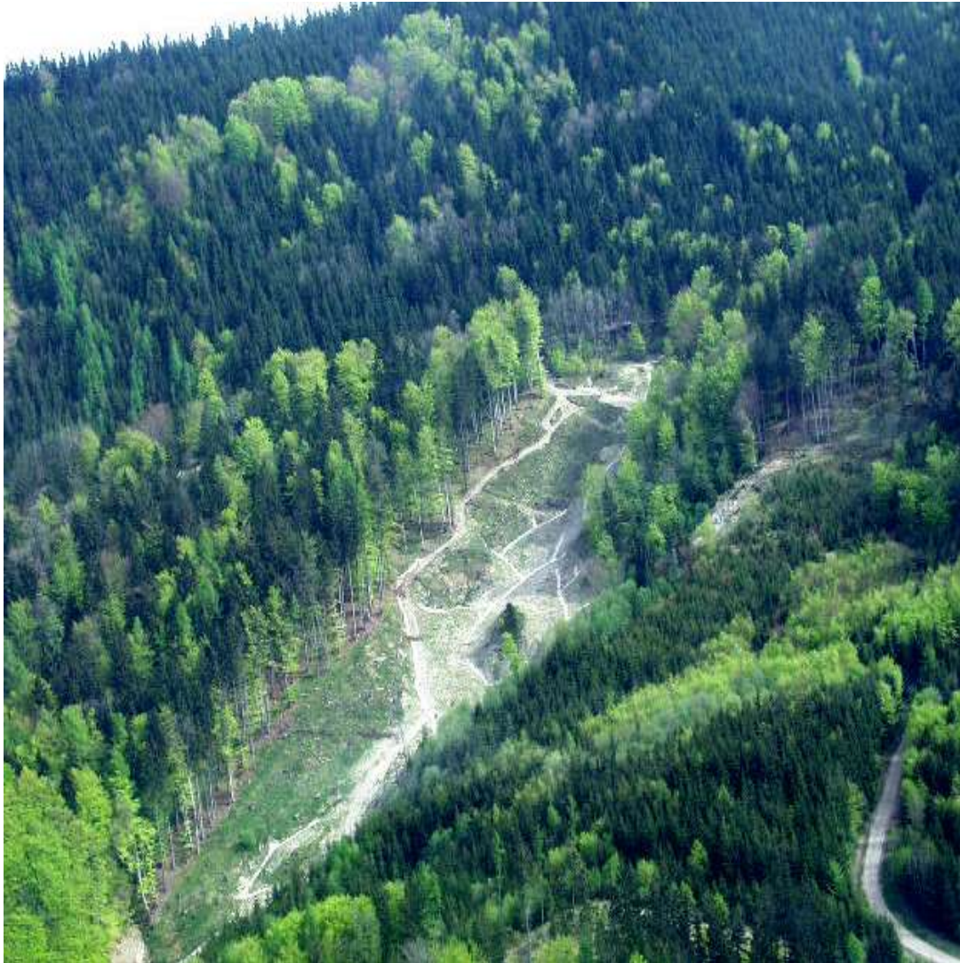
Abb. 5: Entwässerung Fürweg Nord, (Obere Rutschung) Aufnahme: Michael Glück
