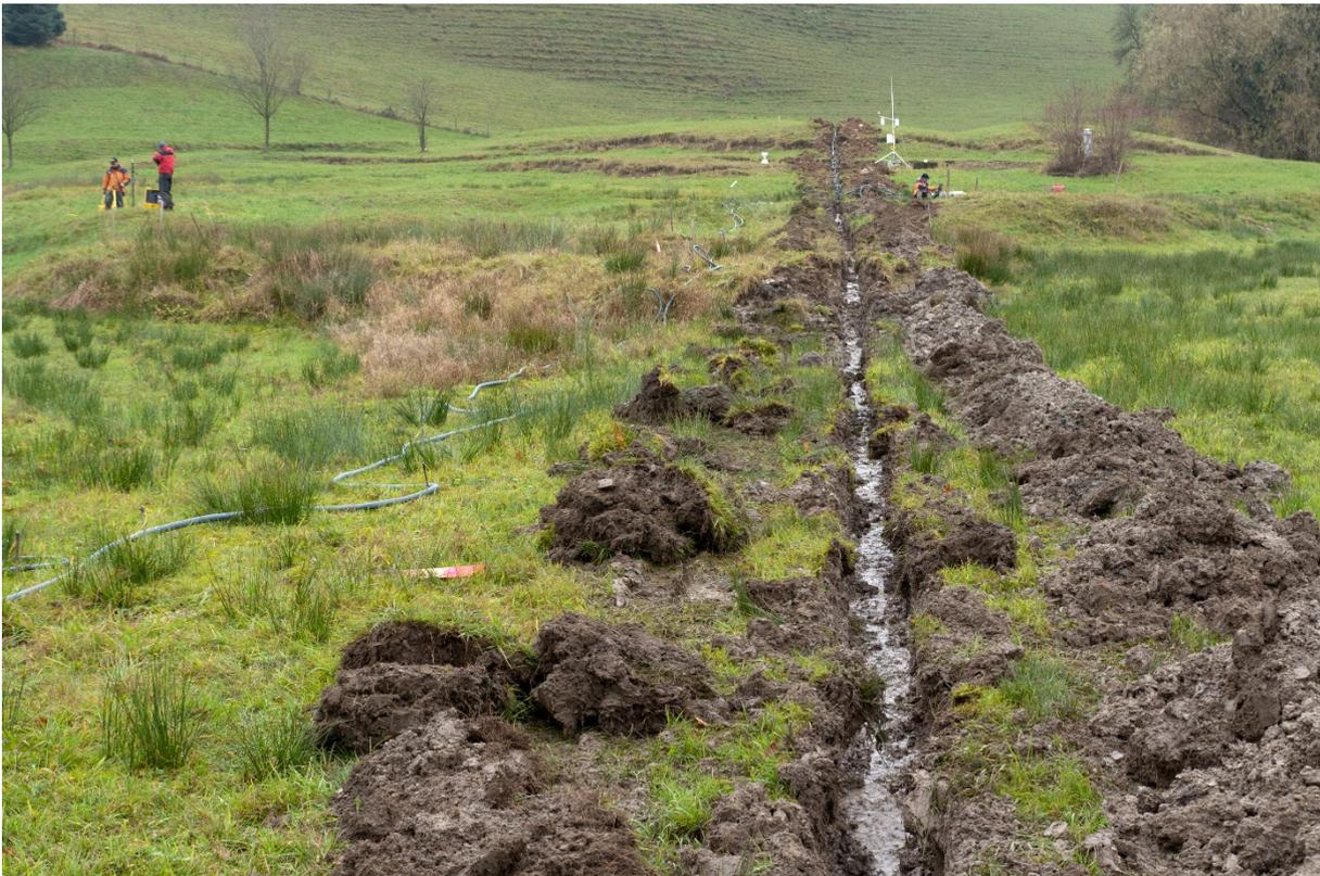
Abb. 9.2.2.: Installation des geoelektrischen Monitorings in Gresten
