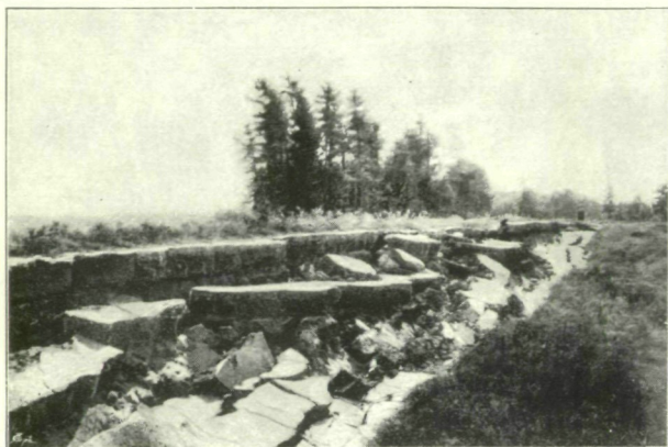
Fig. 1. Erdbebenspalte an den Ufern des Shōnai-gawa bei Biwashima unweit Nagoya.
