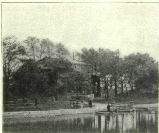
Fig. 1. Die Badeanstalt bei Röblingen vor dem Wassereinbruch.
