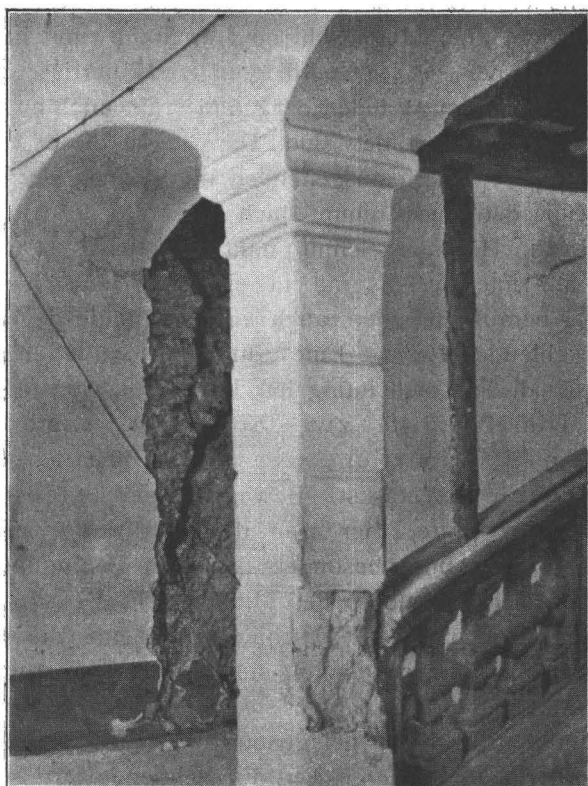
Fig. 1. Vertikalriß zwischen dem Haupttor des Attems'schen Schlosses und dem Kreuzgang des Mittelhofes.
