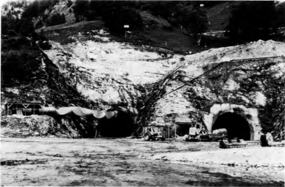
Abb. 123: Südportal des Autobahn-Tauern隧nells bei Wald im Zederhautal (Lungau, Salzburg) während des Baues im Jahre 1971. Dieser Tunnel verbleibt in seiner gesamten Länge von 6.353 m in der mäßig nordfallenden penninischen Schieferhülle, welche die im Bereich des Tunnels auflagernden älteren, triadischen Kalke und Dolomite des Unterostalpins der Radstädter Tauern tektonisch flach unterlagert. Damit ist durch diesen Großaufschluß ein neuer Beweis für den Deckenbau im Bereich des Tauernfensters erbracht worden.
