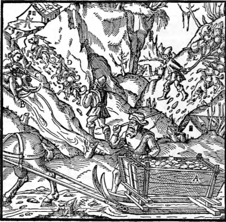
Abb. 1: „Schlitten- und Sackzugförderung in den Alpen.“ Holzschnitt aus G. AGRICOLA „De re metallica“ (1556).
