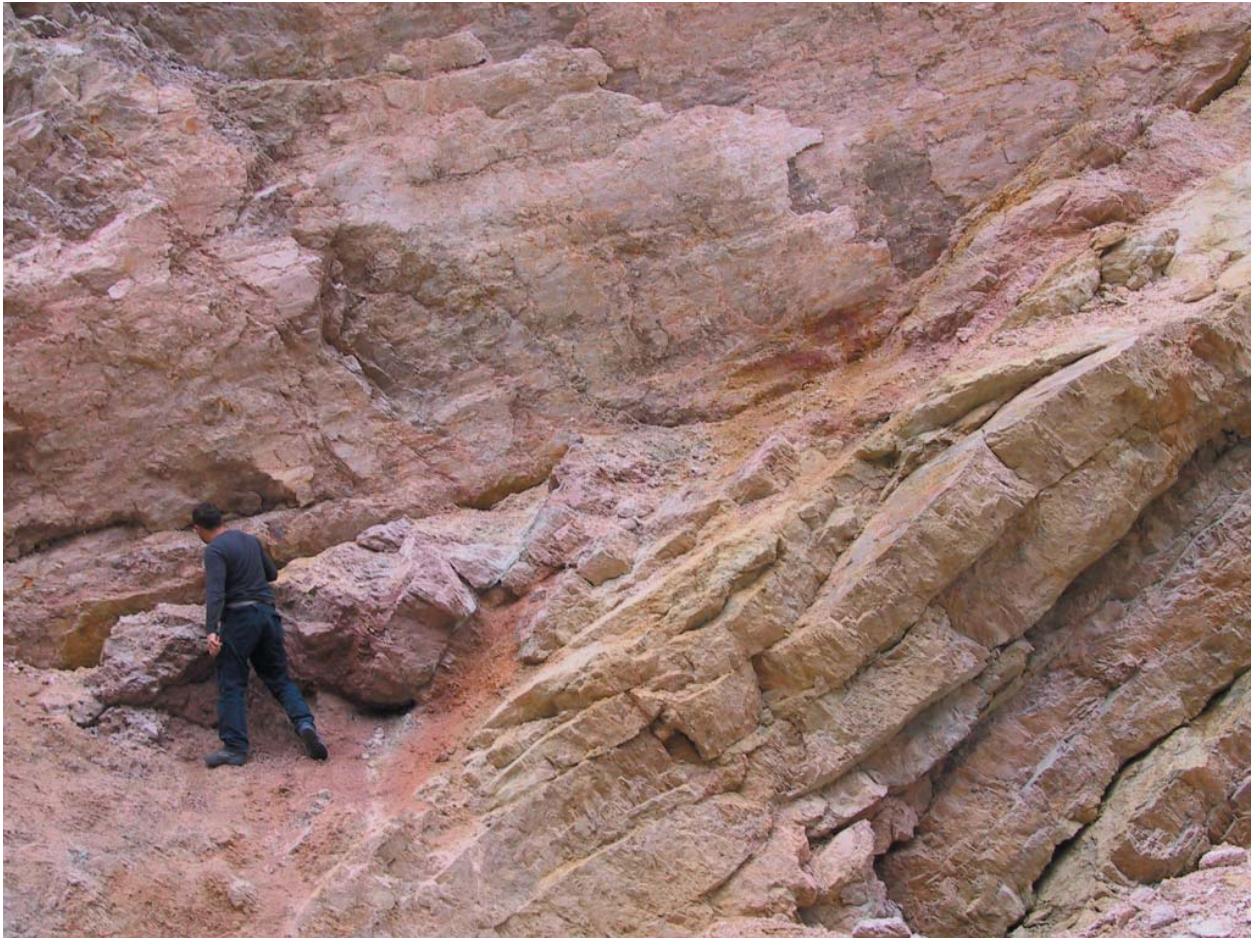
Abb. 44: Wandbildende, dextrale Seitenverschiebungen im NW-fallenden Hauptdolomit in der Schlucht südlich der Erz.-Joh.-Klause. Die von links hinten in die Hauptscherfläche einmündenden Riedel-Scherflächen bilden ein eindeutiges Schersinnkriterium.
