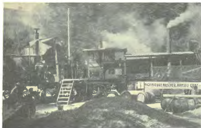
Abb. 2. Fahrbare Asphaltaufbereitungsanlage im Betriebe am Opernring.
