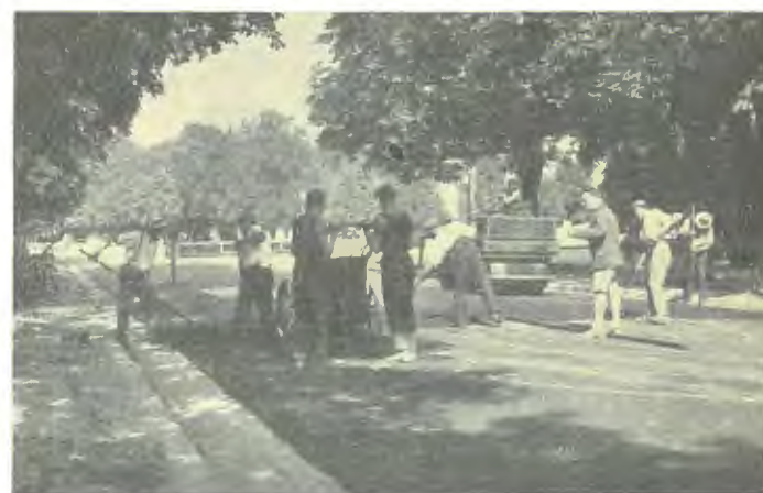
Abb. 3. Aufbringen der Walzasphaltschichte auf vorbereitetem Makadamuntergrund.
