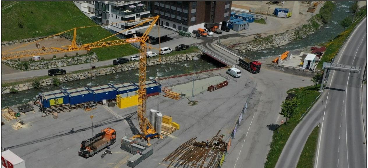
**Abb.8:** Reinigungsanlage für Bohrwässer der Erdsondenanlage (blaue Container links)
