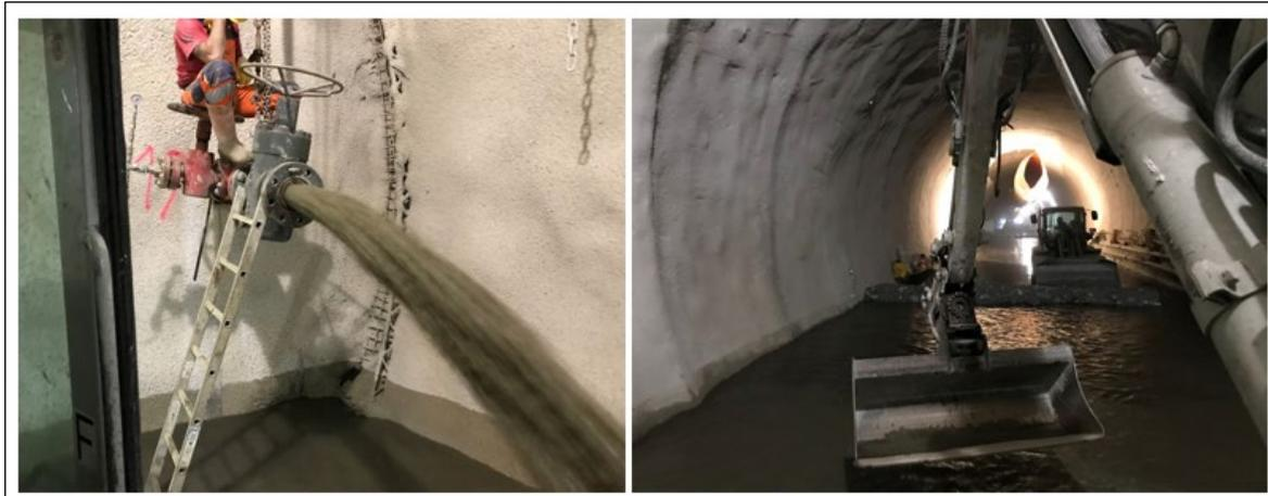
**Abb. 15:** Auslaufversuch an der VEK 119 vom 01.12.2022 und mit Wasser aus dem Auslaufversuch gefülltes Becken
