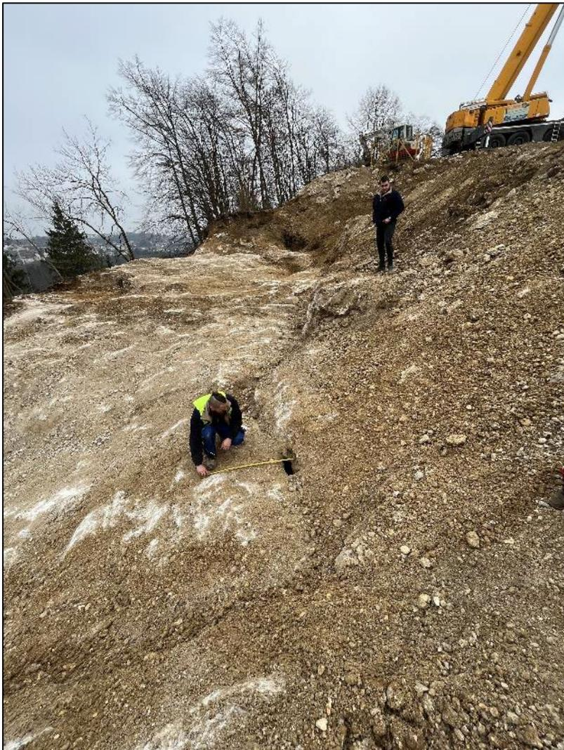
**Abb. 6:** *Kluft böschungsparell und mehrere Meter hinter der Böschungskante (2023 nach Felssturz-Ereignis)*
