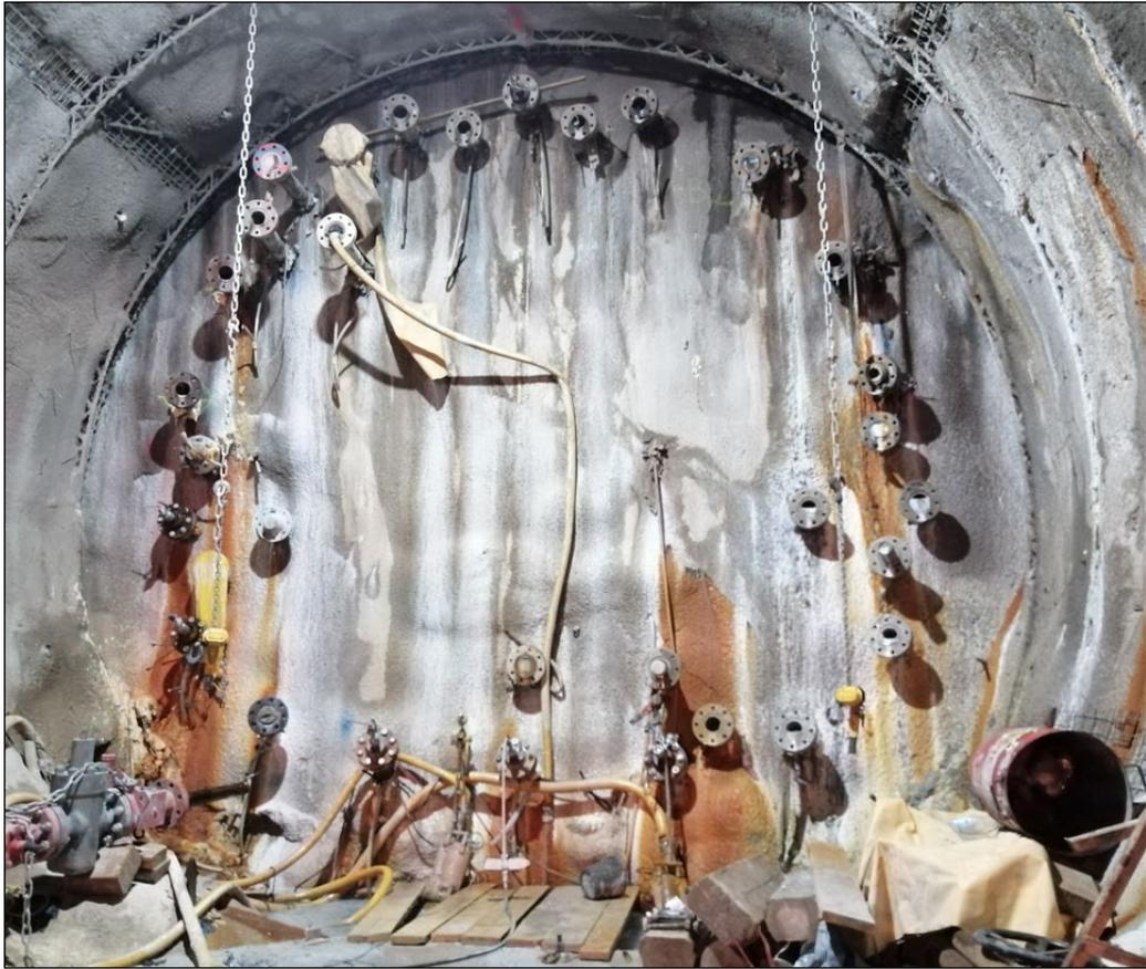
**Abb. 12:** Ortsbrust mit Injektionsbohrungen
