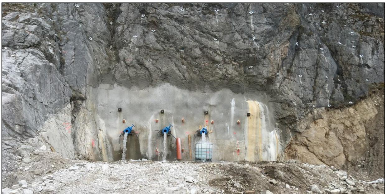
**Abb. 7:** Fertiggestellte Horizontalbohrungen mit Austritt der erschlossenen Wassermenge [Foto Ingenieurbüro ZT GmbH Gstrein & Partner, Stand: 21.11.2018].
