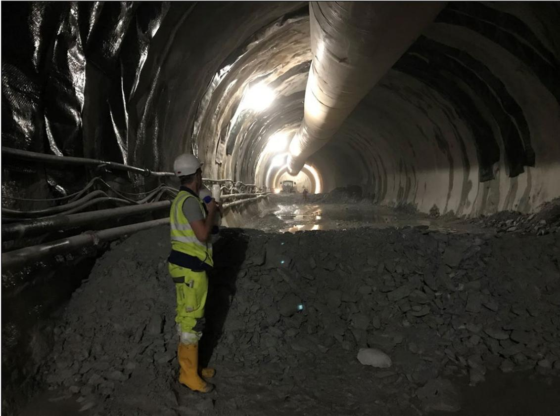
**Abb. 14:** Im Vordergrund geschütteter Damm aus Ausbruchsmaterial und dahinter ein Absetzbecken im Erkundungsstollen für den Auslaufversuch an der Vorauserkundungsbohrung VEK 119 bei der Ortsbrust bei TM 4.552,40 bzw. PK 29.850,56
