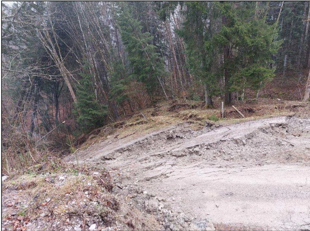
*Abbruch an der Abzweigung (=Messstelle), seitliche Verschiebung: ca. 70 m*
