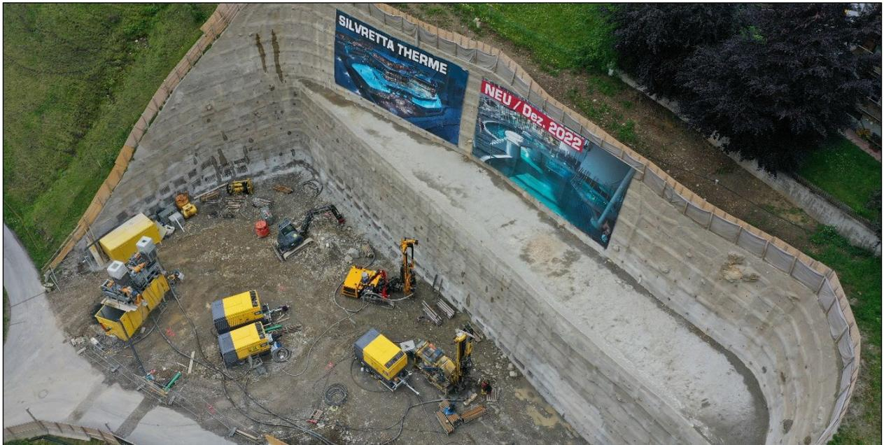
**Abb.7:** *Geräteinsatz (3 Bohrergeräte, Entsandungsanlage, Kompressoren) der Bohrarbeiten für Erdsondenfeld*
