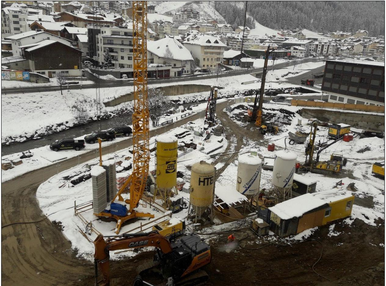
**Abb.6:** Geräteinsatz während Bohrarbeiten für Grundwasserbrunnen (Pfählmachine hinten)
