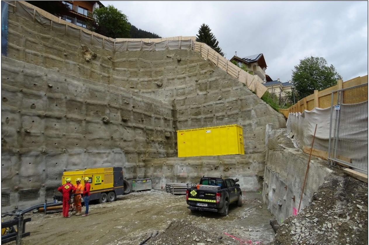
**Abb.4:** Baugrubensicherung „Satelliten-Gebäude“
