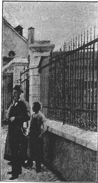
Fig. 8. Verdrehungen und Verrückungen bei einem Thorpfeiler (Bahnhofstraße)
