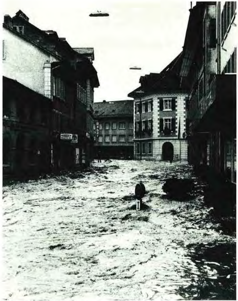
Hochwasserentlastung der Langeten durch eigens dafür ausgebaute Straßen von Langenthal. Die Gehsteige liegen meterhoch über dem Straßenniveau.
