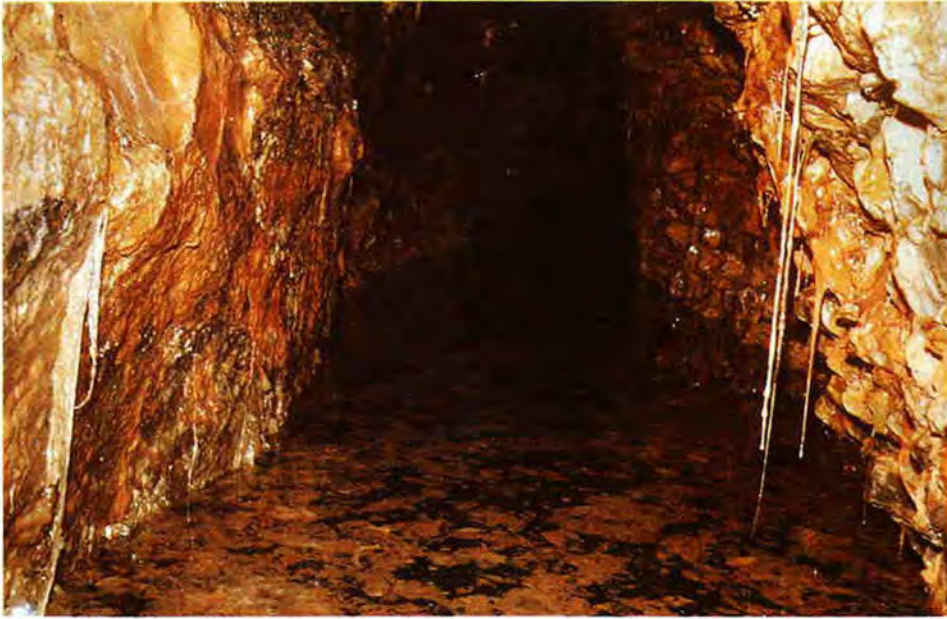
Tafel III: Schleimige Überzüge von eisenabscheidenden Bakterien auf der Stollenwand, z. T. als Schnüre herabhängend. Wasseroberfläche dicht mit Fladen aus Abbauprodukten des Mineralöls bedeckt.
