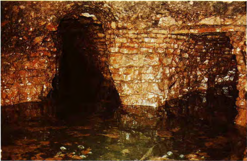
Tafel I: Stollenverzweigung im Nodositas -Kalk rd. 20 m vom Stolleneingang entfernt. Der rechte Stollen endet nach 5 m. An den Wänden leicht rostrote Überzüge von eisenabscheidenden Bakterien. Auf der Wasseroberfläche Flusen und Blasen von Biomassen.
