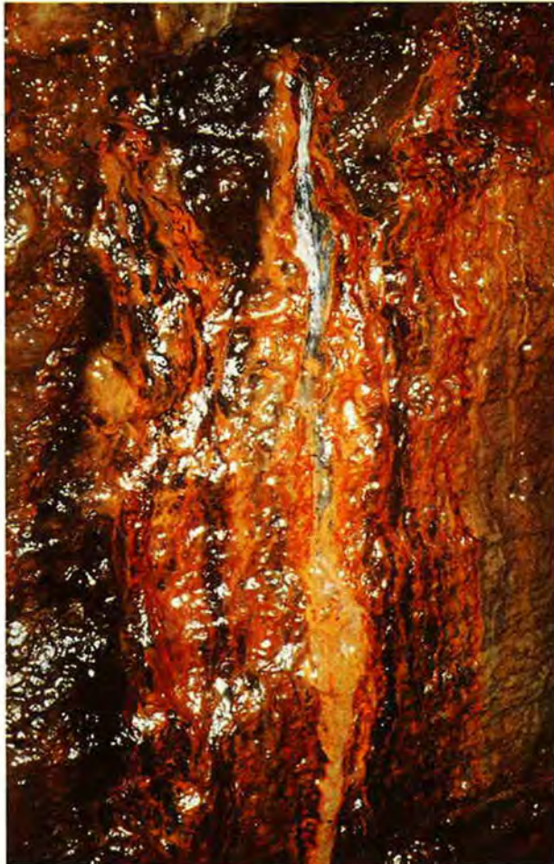
Tafel III: Schleimige Überzüge von eisenabscheidenden Bakterien auf der Stollenwand, z. T. als Schnüre herabhängend. Wasseroberfläche dicht mit Fladen aus Abbauprodukten des Mineralöls bedeckt.
