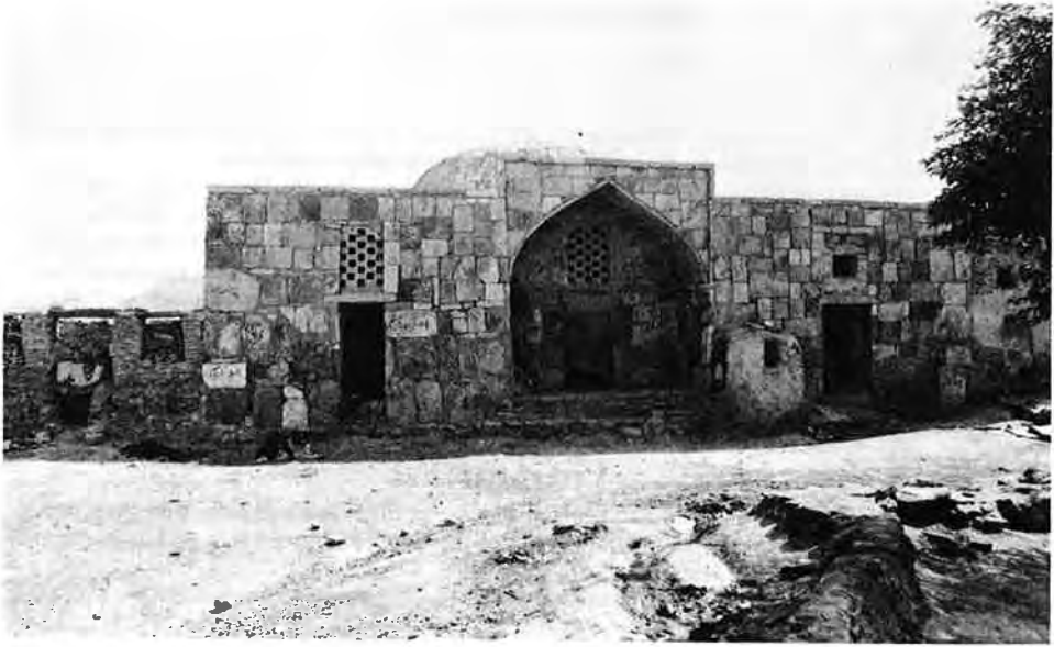
Fig. 5: Hose Morad Halle (Außensicht).
