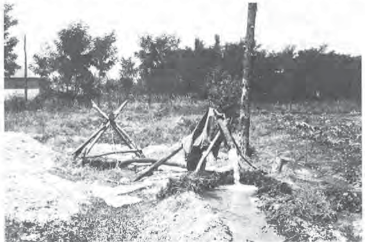
Fig. 16: Flacher Schachtbrunnen zur Furchen-Bewässerung (Foto: F. ISSERINKHUISEN).
