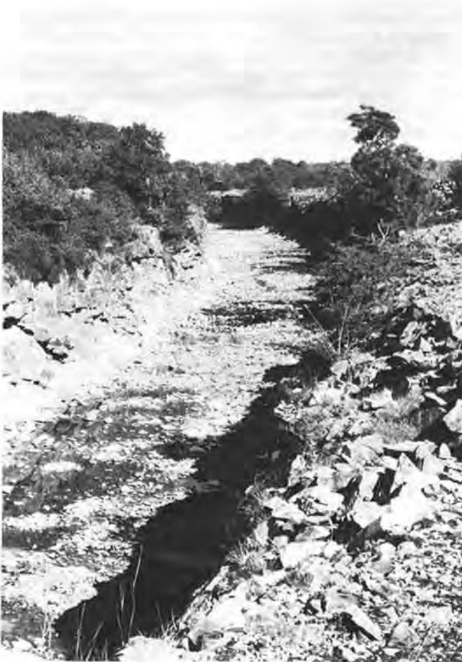
Fig. 19: Der Cong-Kanal (vgl. Fig. 1 und 15), ein mißglückter Versuch, eine schiffbare Verbindung zwischen Lough Mask und Lough Corrib zu schaffen (Foto: J. ZÖTL, 1977).
