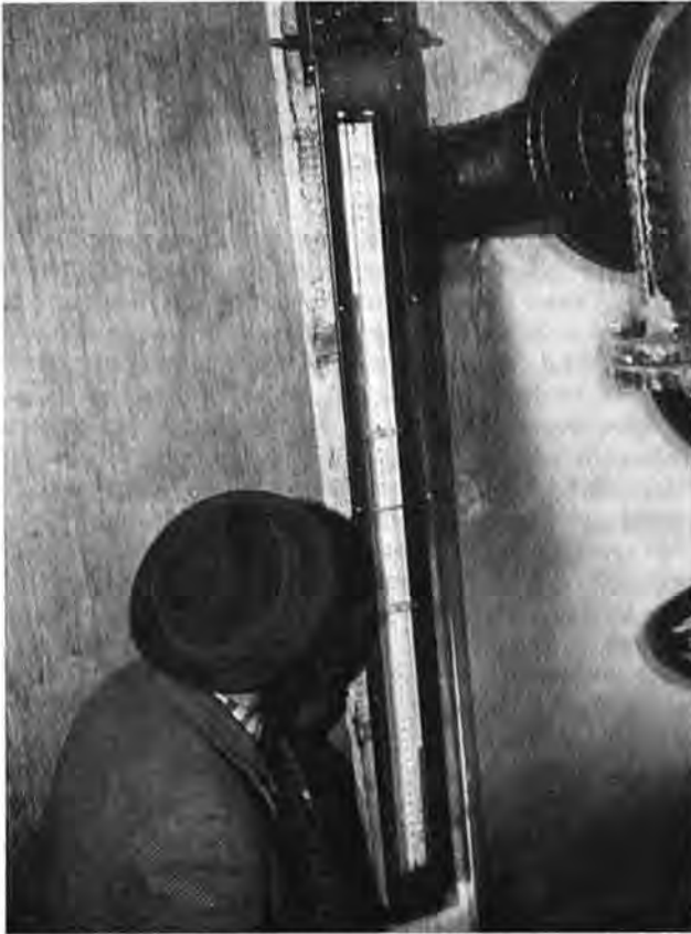
Fig. 4: Optisch abzulesender Quecksilberhydrometer zur Messung des Ruhespiegels in den Thermalwasserbohrungen.
