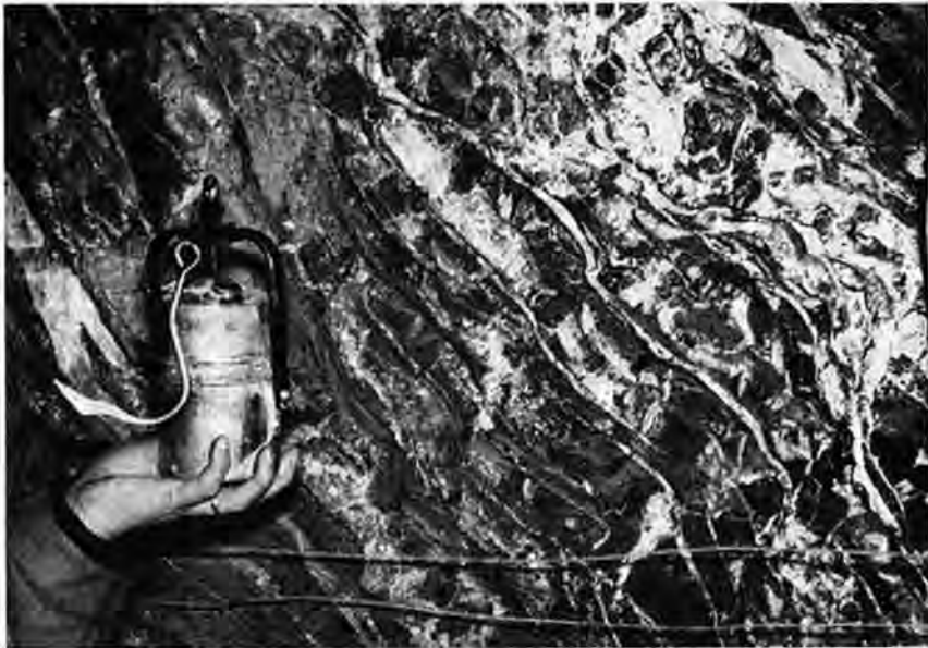
Fig. 3: Langenberg-Sohlstollen, Gipsgebirge (weiß = Gips, grau = sandiger Tonschiefer bzw. Anhydrit).
