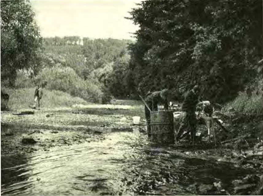
Fig. 62: Einspeisung von 45 kg braungefärbten Lycopodiumsporen in die unterste Schluckstelle der oberen Donau beim Fluß-km 174 + 325 (Foto: W. Käss, 26. August 1969).
