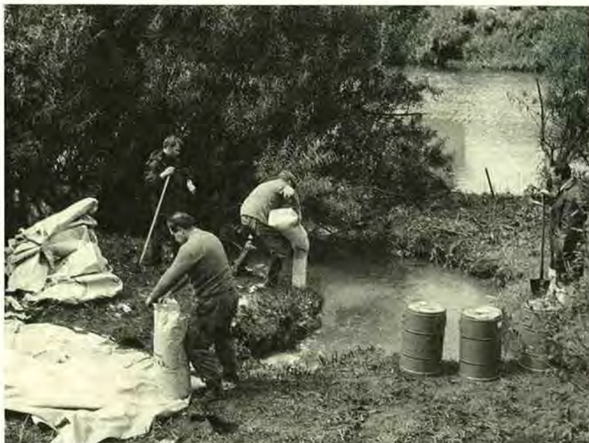
Fig. 37: Eingabe von Kalidüngesalz in die Immendinger Donauschwinden (Foto: W. Käss, 1969).
