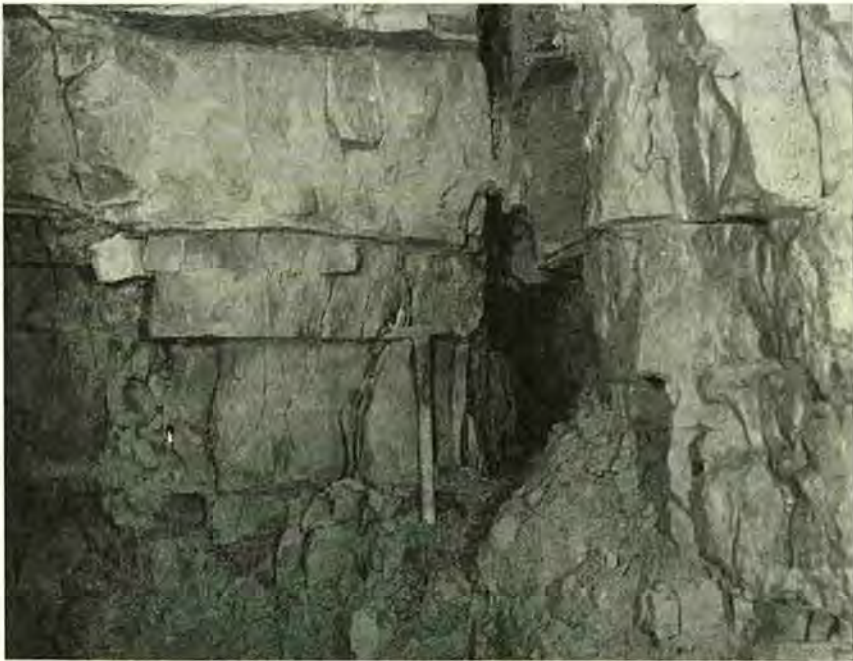
Fig. 8: Donau-Umleitungsstollen, 1624 m. Erweiterte Kluft im Oxfordkalk (Hammer als Maßstab, 40 cm lang; A. SCHREINER, 1968).
