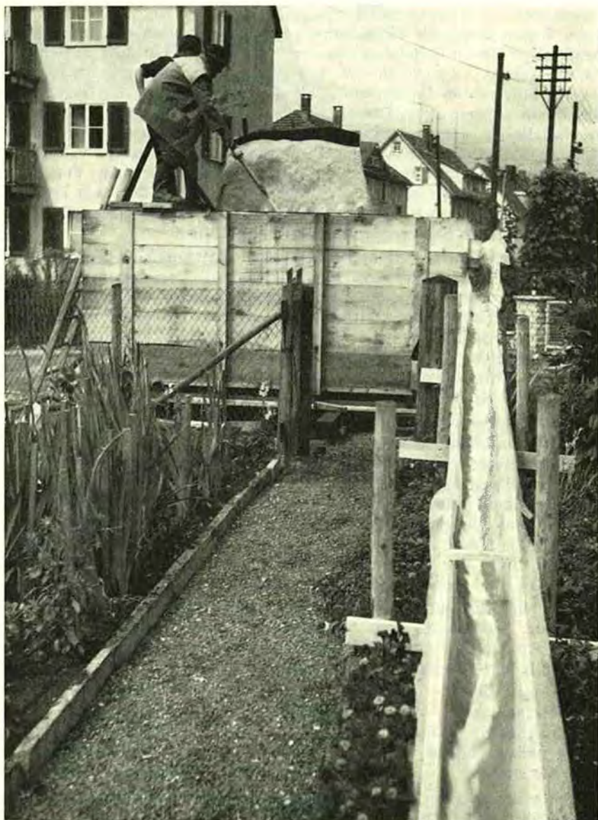
Fig. 67: Einbringung des Salzes mit einem Schaufellader in den Holzbottich zur Auflösung. In einer ausgekleideten Holzrinne fließt die Sole in den Sickerschacht (Foto: W. Käss, 1969).
