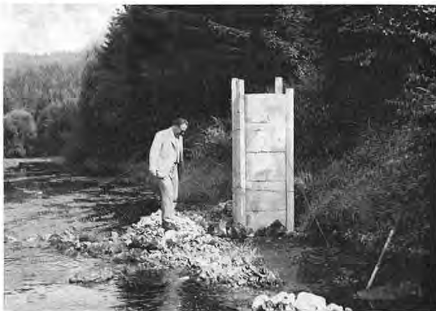
Fig. 40: Mit Brunnenringen ausgebaute Schluckstelle in der Fridinger Donauschleife (Foto: W. Käss, 1969).
