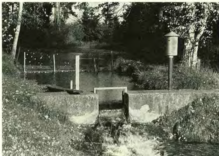
Fig. 20: Der Quellteich der Bleiche (Beobachtungsstelle Nr. 18) östlich von Welschingen. Im Vordergrund ein 60 cm breites Rechteckwehr mit Schreibpegelanlage (Foto: H. Hörzl, 1969).
