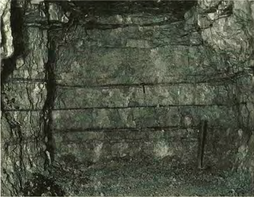
Fig. 7: Donau-Umleitungsstollen. Ortsbrust bei 1668 m, Oxfordkalk (weiß) ungestört, ohne Klüftung, ohne Verkarstung (rechts unten ein Pickel als Maßstab; Foto: A. SCHREINER, 1968).
