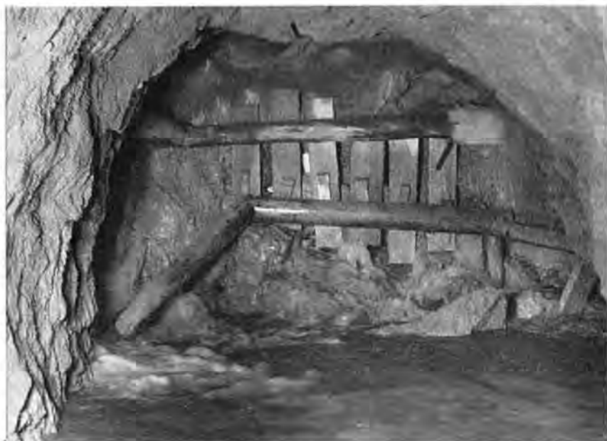
Fig. 4: Stollenbrust im Südtrum des Schneetalstollens bei Stollenmeter 637 zur Zeit des großen Wassereinbruches im Juli 1966. Foto: Wiener Wasserwerke, 1966.
