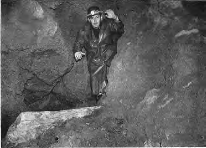
Fig. 5: Begehbare Hohlräume in der wasserführenden Kluftzone des Südturms (Umfahrungsstollen). Foto: F. Bauer, 1966.
