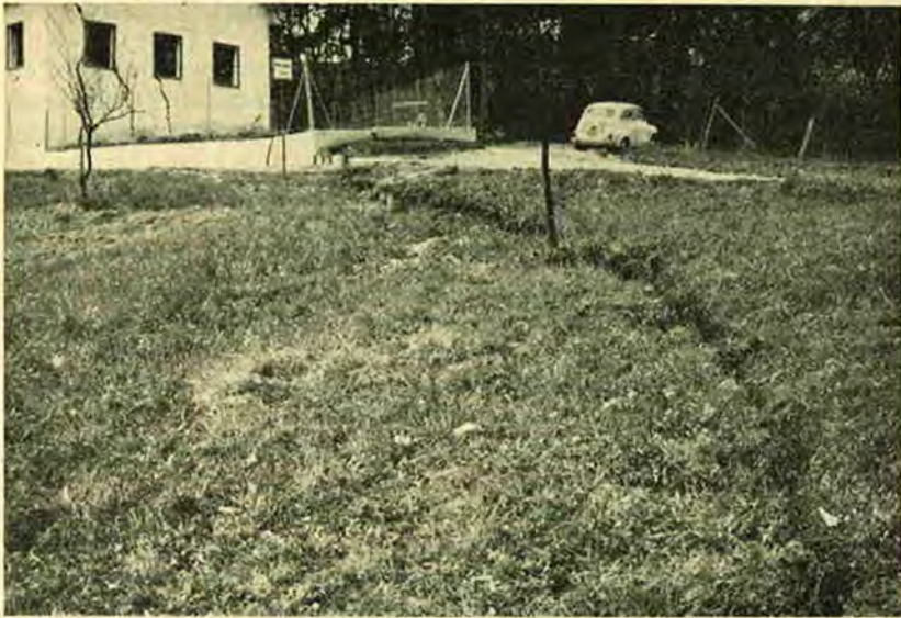
Abb. 3: Rutschung in Rohrbach. Die Absetzung der Hanglehme verursachte eine Zerreiung und Verstellung der Gartenmauer sowie 4 bis 6 cm weite Sprünge in den Hauswänden.
