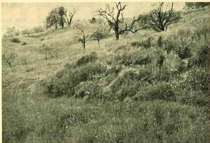
Abb. 9: Rutschung an der Bundesstraße Gleisdorf—Pesendorf. Die ausgequetschten Hanglehme schieben sich am unteren Ende der Rutschung vor.
