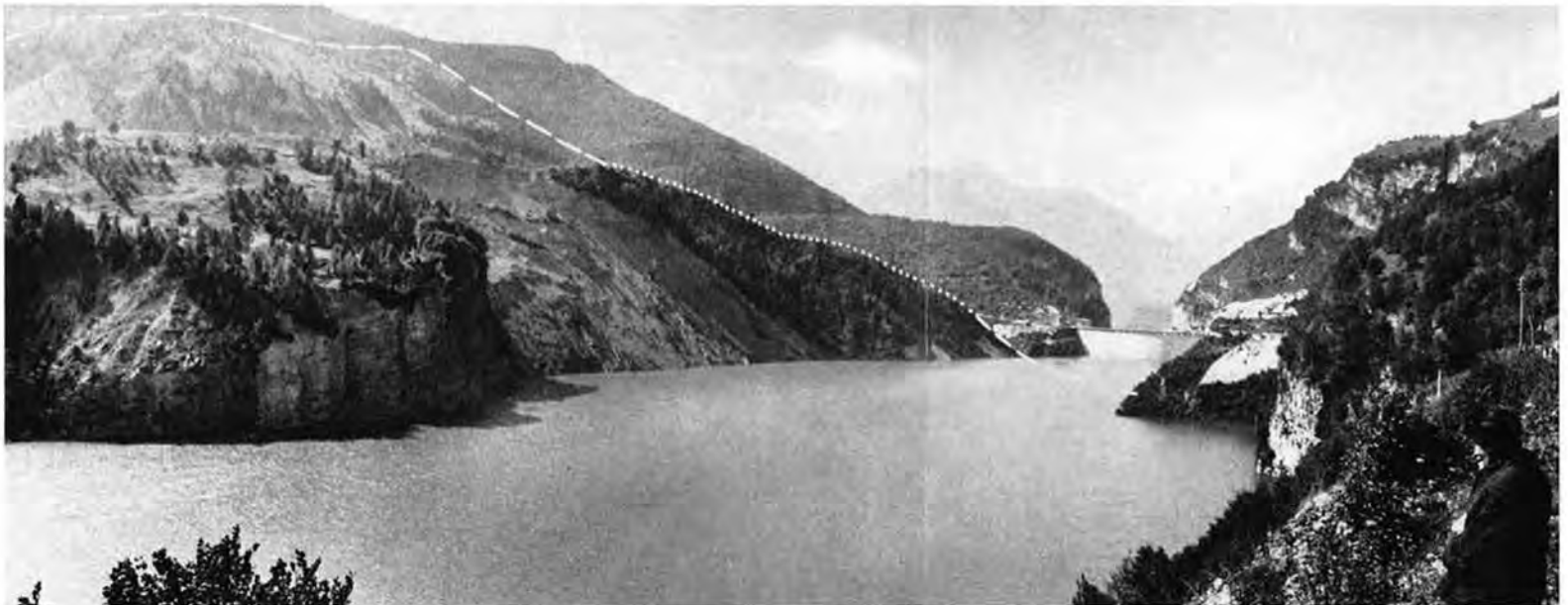
Abb. 9: Als Vergleich zu Abb. 8 — der Monte Toc-Nordhang vor der Gleitung. Standpunkt 1 km östlich der Sperre bei Stauhöhe ca. 695 m. Im Hintergrund ist die westliche Abrisflinie skizziert. Man vergleiche die linke Schulter südlich der Sperre in Abb. 10. Die linke Felsbarriere zeigt Ablösungen von Felspfeilern, anschließend der Rutsch des Jahres 1960.
