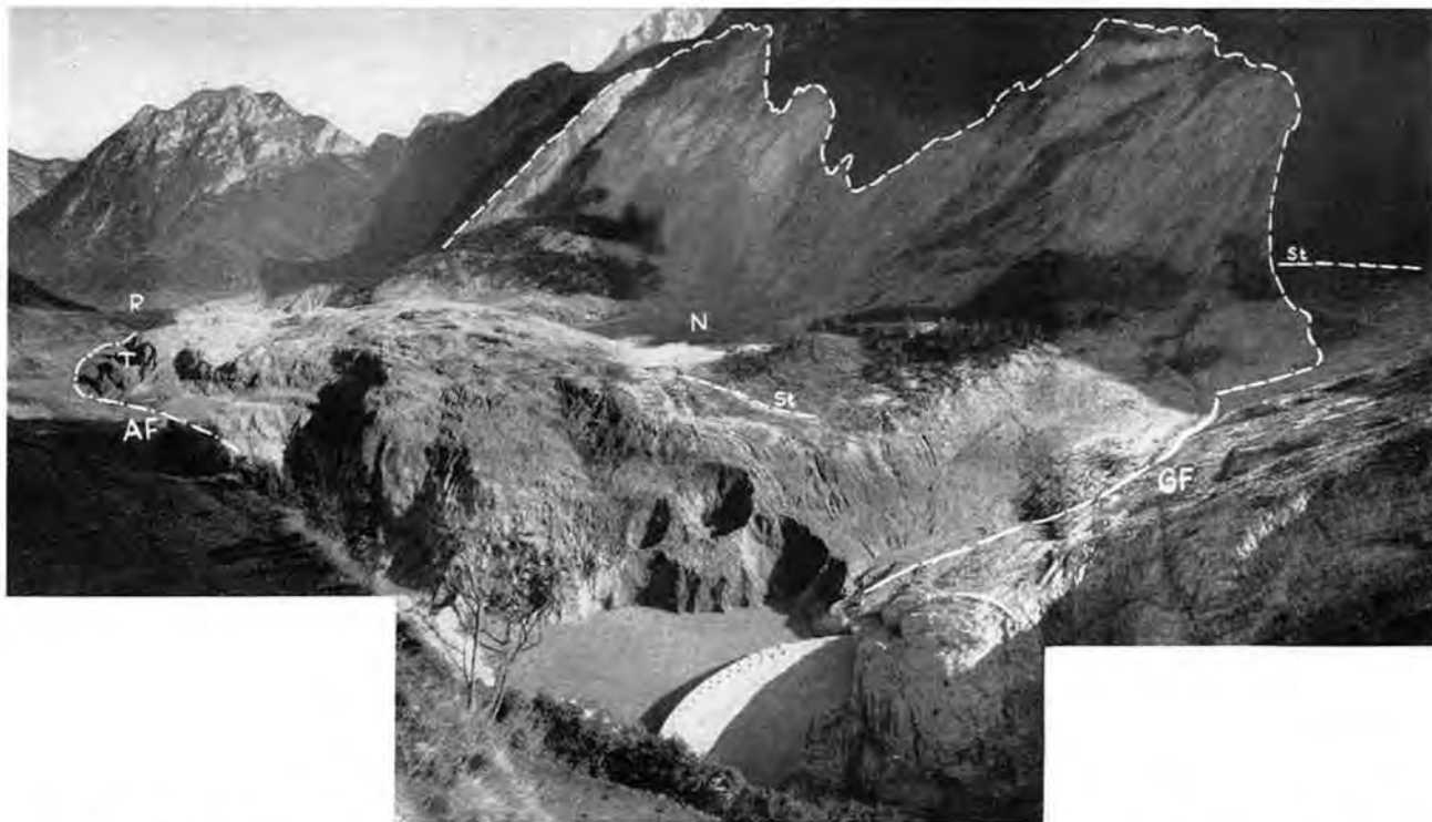
Abb. 4: Gesamtansicht der Felsgleitmasse des Monte Toc. 600 bis 700 Mill. m^3 wurden bewegt, wovon 250 Mill. m^3 den früheren Stauraum bedecken. Markiert sind die zwei Abrißschalen, die Gleitfläche über der Mauer (GF), der Nackensee (N), die Aufschiebungsfront (AF) mit dem „Schluchtturm“ (T) und der Reststausee (R). Im Vordergrund die beschädigte Semenzmauer, der kleine Restwassersee und die Einsturztrichter. Man beachte ferner den Verstellungsbetrag an der abgerissenen Straße (St).
