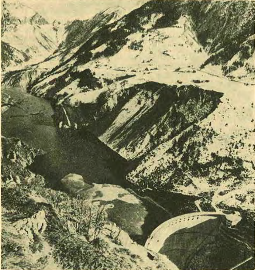
Abb. 3: Blick auf die Monte Toc-Seite mit der glazial überprägten Ver- ebnung, auf der die Almen von Pian di Toc liegen. Diese For- mgebung wird auf einen alten Talzusub zurückgeführt. Die Aufnahme zeigt die Situation nach dem Rutsch von 1960. (Nach G. SCHNITZER 1964.)
