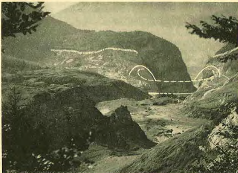
Abb. 10: Die Felsmassen im Stausee. Hinter der Mauer türmt sich felsiges, schuttiges und erdiges Material. Im Vordergrund die Stirnfront mit dem „Schluchtturm“ und die Aufschiebungsfront, die ident mit der Abflußrinne ist. Links der Mauer die 120 m hoch hinaufreichende Schwallgrenze und tiefer die hufeisenförmige Überlauflinie.
