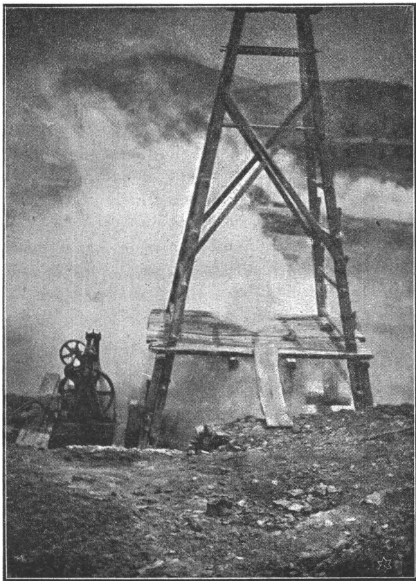
FIG. 3 a . — Soffione prodotto da foro artificiale a Serrazzano.
