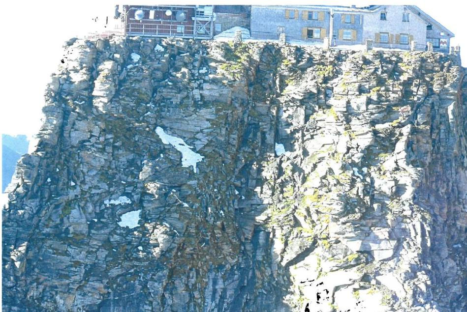
Foto 4: Ansicht der Zentralen Nordwand mit charakteristischem Gebirgstrennflächengefüge, in Bildmitte die „markante Ausbruchsnische“ („Zerrüttungszone“)
