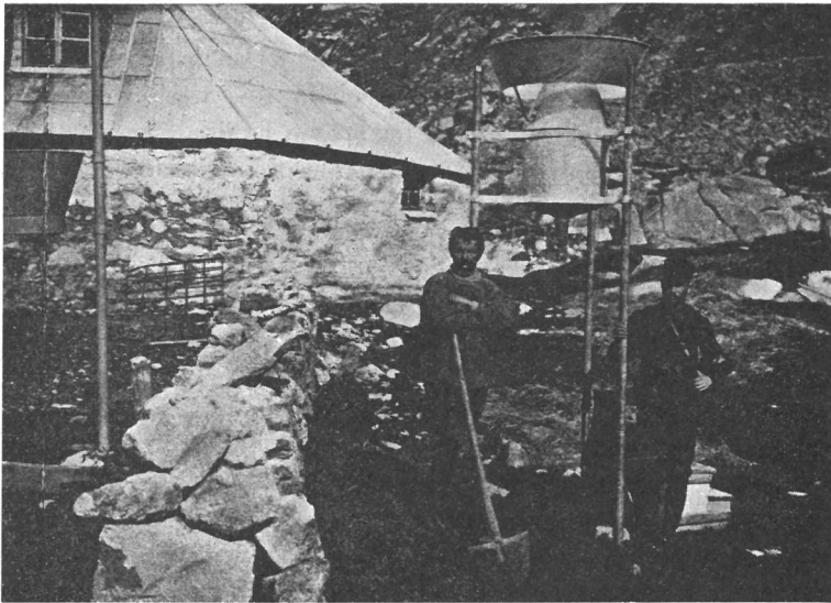
Totalisator auf dem St. Gotthardpaß, wo sein Funktionieren während eines Jahres überwacht und das Resultat mit den Ergebnissen eines täglich bedienten geschützten Ombrometers verglichen wurde. Die Übereinstimmung war eine vollständige.
