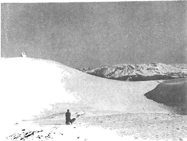
Observatorium aus der Ferne von West.
