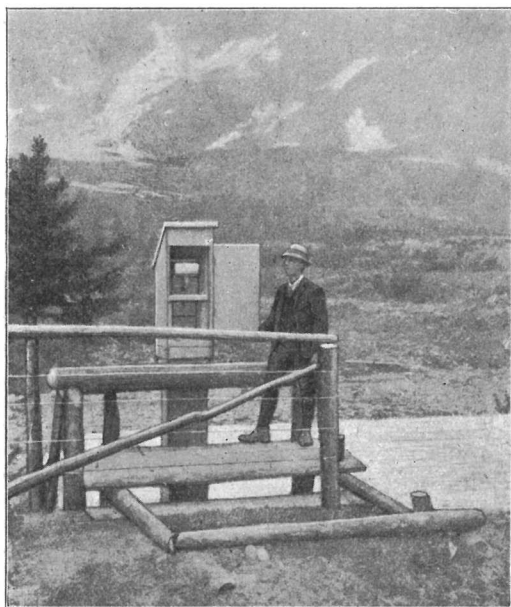
Abb. 2. Limnigraph in Kolm-Saigurn, vom rechten Bachufer aus gesehen.
