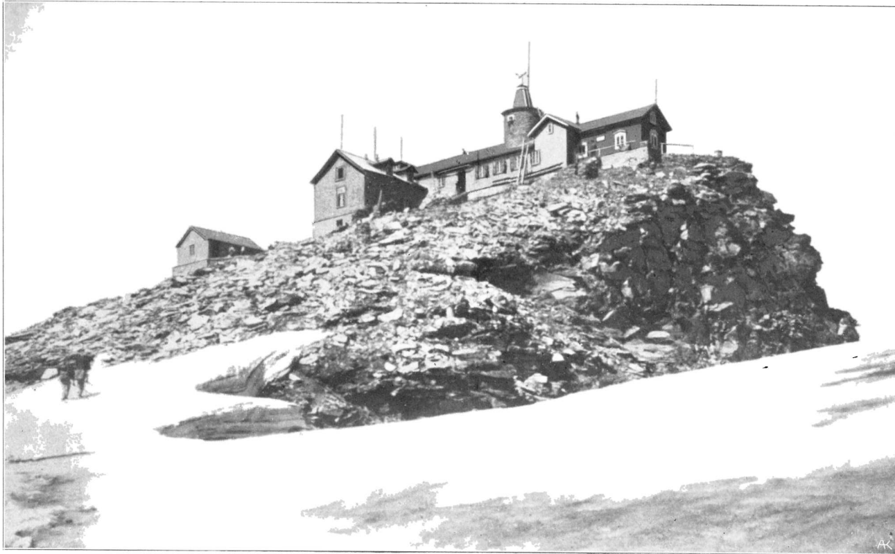
Der Sonnblickgipfel mit dem durch den Zubau im Jahre 1910 vergrößerten Zittelhause und der im Jahre 1911 erbauten Beobachtungshütte.
