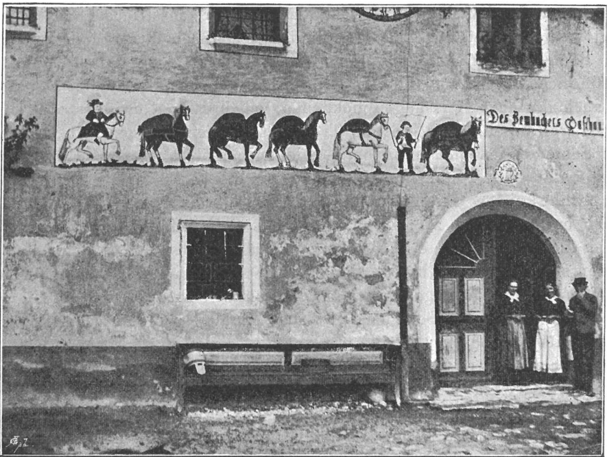
Bilderfriess auf Zembacher's Gasthaus in Wörth.
