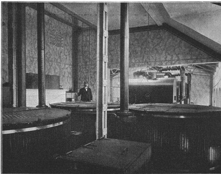
Fig. 128. Sprudelwasserzulauf und Entsinterung.
