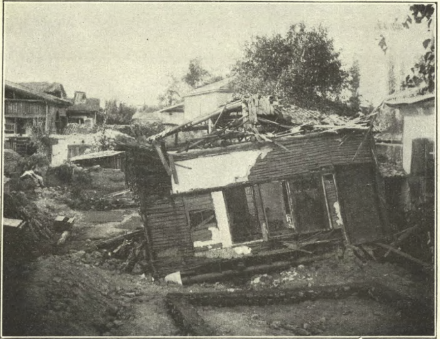
Fig. 204 Von seinem Unterbaue weggeschobenes Haus in Denizli, Mäandertalbeben, Kleinasien 1899 (nach einer käuflichen Photographie)
