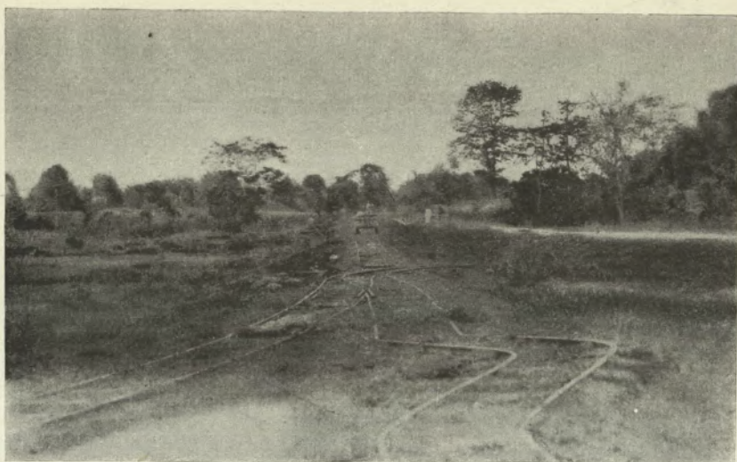
Fig. 200 Gebogene Schienen bei Rangapara, Indien, Erdbeben am 12. Juni 1897 (nach R. D. Oldham)
