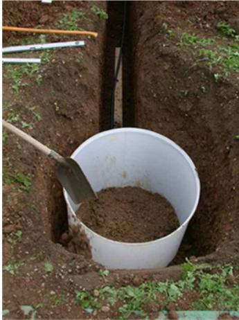
Abbildung 11.15. Einbau Lysimeter Schwertberg, Quelle: LWK OÖ
