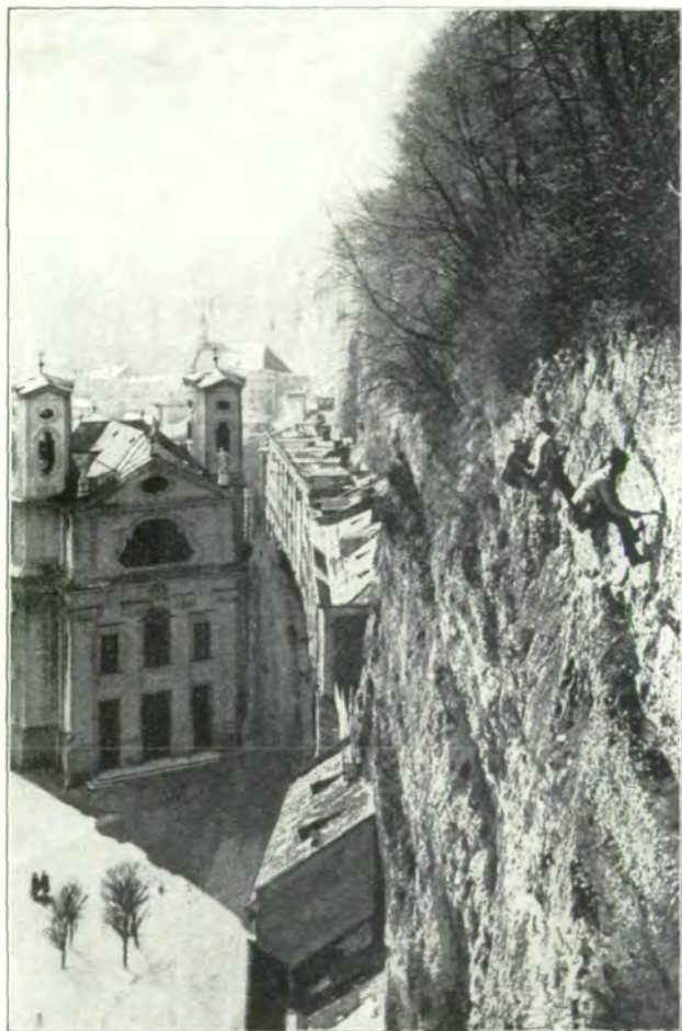
Taf. I. Die „Bergputzer“ am Mönchsberg bei Salzburg. Im Frühjahr wird das durch die Fröste gelockerte Gestein entfernt, damit es keinen Schaden stifte. (Auch am Leopoldsberg bei Wien.)
