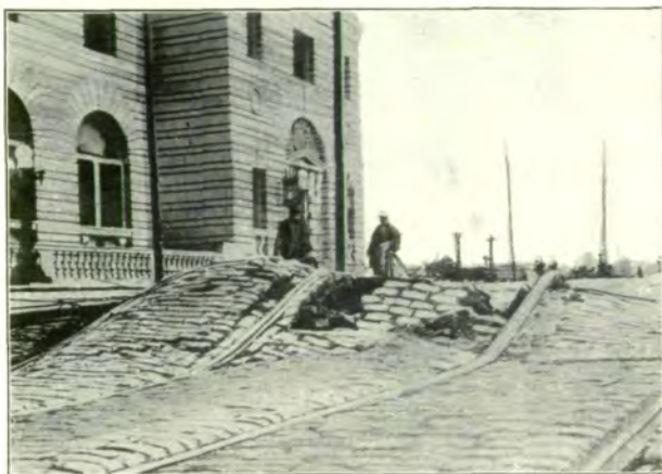
Fig. 15. Eine Folge des Erdbebens. Mission Street, San Francisco.
