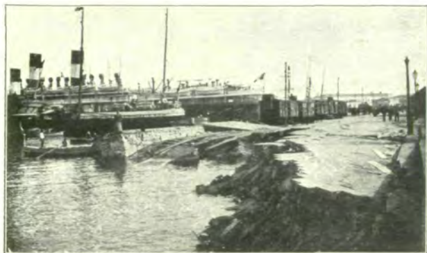
Fig. 11. Abbrüche und Versenkungen am Kai von Messina.
