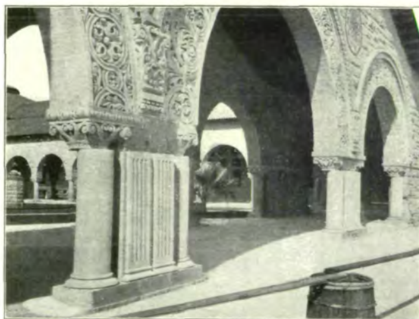
Fig. 16. Erdbeben von San Francisco, 18. April 1906. Verschiebung des Deckengewölbes an der Leland Stanford junior-Universität.
