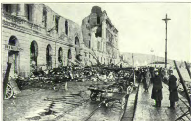
Fig. 6. Ein Teil des Corso Vittorio Emanuele nach dem Erdbeben.
