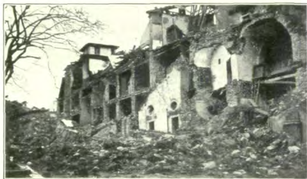
Fig. 8. Häuser, deren Fassade abgeworfen wurde.
