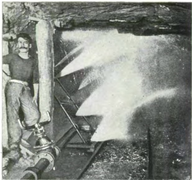
Kühlung der Luft durch Zerstäubung kalten Wassers.
