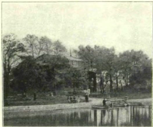
Fig. 1. Die Badeanstalt bei Rößlingen vor dem Wassereinbruch.
