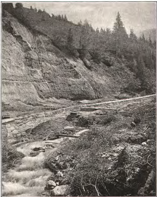
Fig. 40. Sifitzgraben (rechtes Ufer der Drau) oberhalb Sachsenburg. Zweites Leitwerk.
