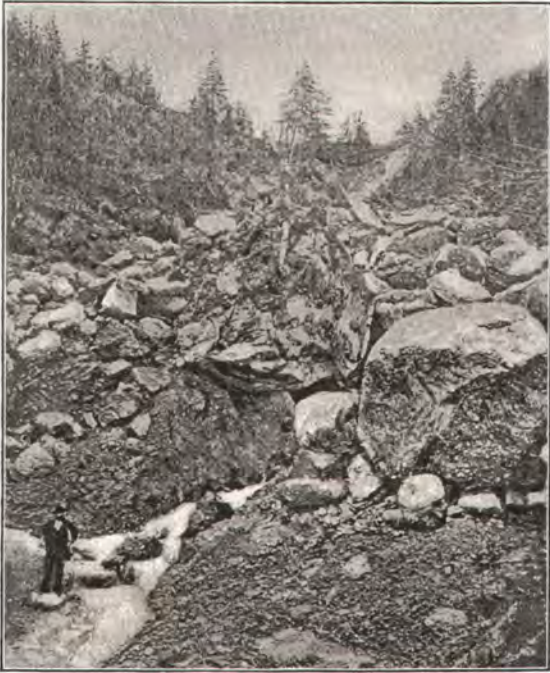
Fig. 33. Spreitenbach (Schwyz). Mutzenbach. Sperre Nr. 5. Vor dem Verbau.
