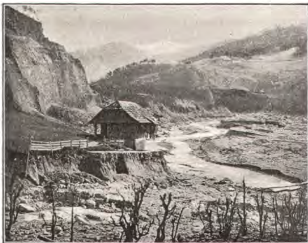
Fig. 23. Verheerung durch den Wielenbach (rechtes Ufer der Rienz, oberhalb Bruneck). September 1882.
