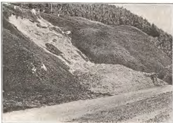
Fig. 24. Eine Abrutschung von der Zufahrtsstraße zum Bahnhof Tarvis.
