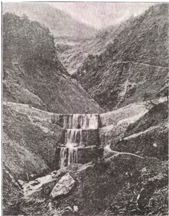
Fig. 29. Thalsperre am Riou chanal, Zufluss des Bachelard (Ubayfluss, Durancesystem), südlich von Barcelonnette, Basses Alpes.
