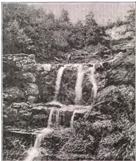
Fig. 34. Spreitenbach (Schwyz). Mutzenbach. Sperre Nr. 5. Nach dem Verbau.
