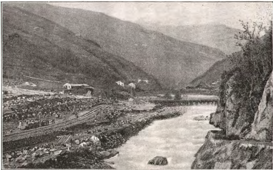
Fig. 3. Das neue Eisackbett bei Kollmann. Arbeiten im Schotterkegel: Neues Zwangsbett.
