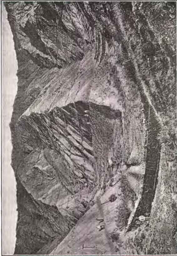
Fig. 27. Perimeter von St. Pons (bei Barcelonnette, Ubaye-Durance). Muschelförmiger Ausriss St. Bernard. Lebende Thalsperren, Aufforstung der Hänge.
