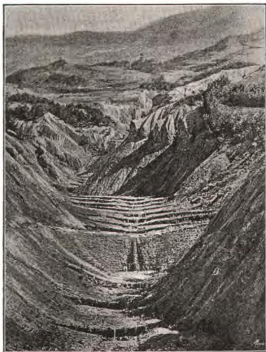
Fig. 30. Rusticalsperre aus Trockenmauerwerk aus dem Wildbachgraben von La Valette in Savoyen (angrenzend an den Wildbach von Riou bordoux).
