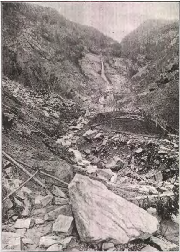
Fig. 9. Bergsturz bei der Mühle im Gandergraben bei Kollmann.
