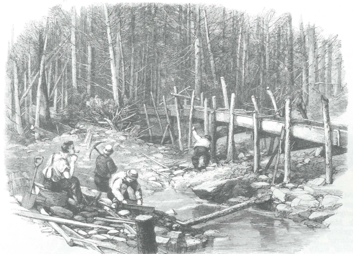
Das zum "Goldwaschen" unbedingt benötigte Wasser mußte oft von weit her geleitet werden.
