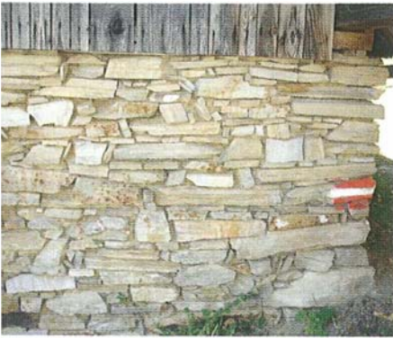
Abb. 198: Trockenmauer aus Granulitplatten, Steinegg am Kamp (Foto F. F. Steiningner)
