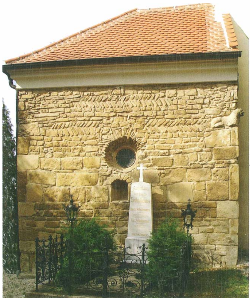
Abb. 203: Sandsteine aus der Laa-Formation, Apsis des romanischen Kirchen- baues in Peygarten an der Pulkau (Foto F.F. Steiningner)
