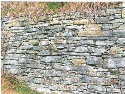
Abb. 199: Trockenmauer aus Amphibolit, Senftenberg (Foto M. Götzinger)
