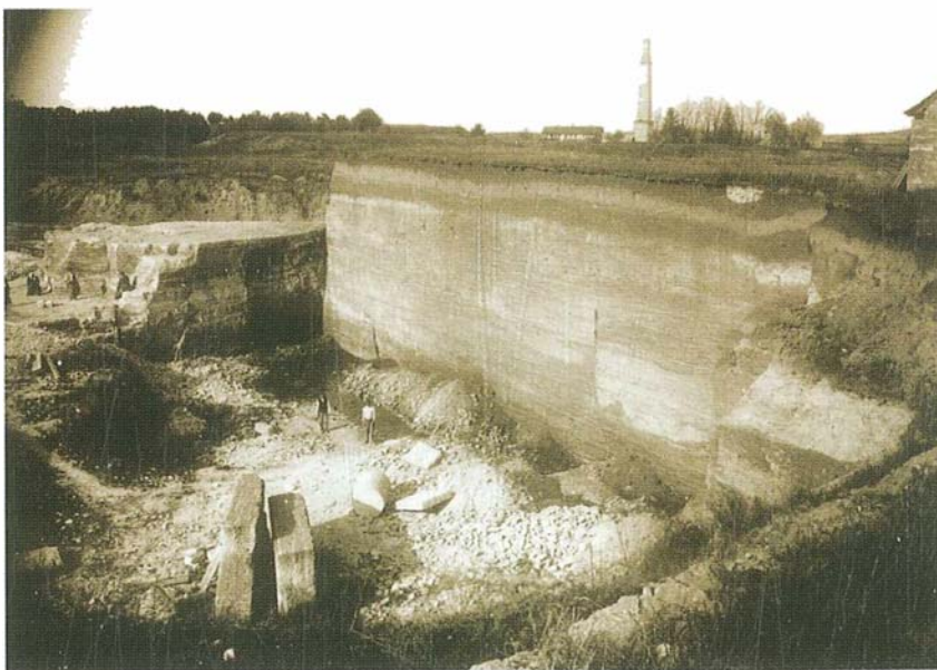
Abb. 202: Zogelsdorf-Formation, historische Aufnahme des „großen Steinbruchs“ westlich von Zogelsdorf (Foto: G. Hiesberger, Eggenburg).
