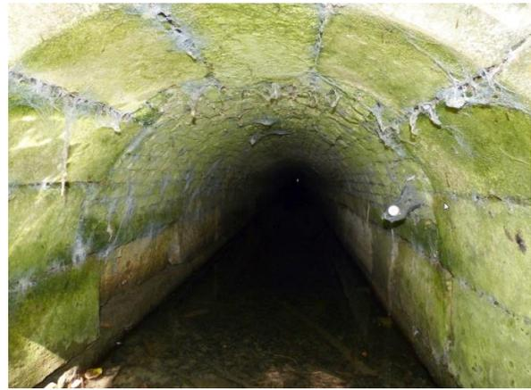
Abb. 68 und 69: südlicher Eingang zum Entwässerungsstollen „Sulzsee“ sowie der Stollenabschnitt dahinter. Der 300 m entfernte nördliche Ausgang ist gerade noch als winziger heller Punkt erkennbar.
