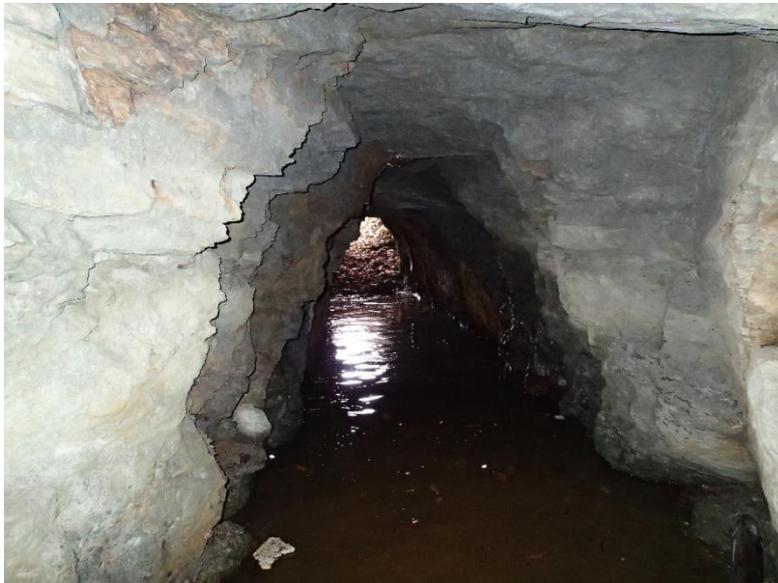
**Beschreibung:** Der 1,5 m breite Stollen verläuft 14 m nach NO. Außer im Bereich des Eingangs, der durch Sedimenteintrag nur noch kriechend befahrbar ist, beträgt die Raumhöhe 2 m und der Stollen ist etwa einen halben Meter hoch mit Wasser gefüllt. Darin befinden sich Bretter, Flaschen und anderer Kleinmüll, der sich leicht entfernen ließe. Um eine Quelle im eigentlichen Sinne handelt es sich bei diesem Objekt allerdings nicht.
