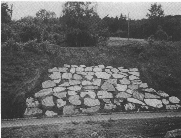
An vielen Straßen in der Umgebung der großen Steinbrüche dienen Wurfsteine aus Marmor der Stabilisierung von Böschungen, hier am Beispiel der Straße im Tal des Rundser Baches von Bernhards nach Doppl.
