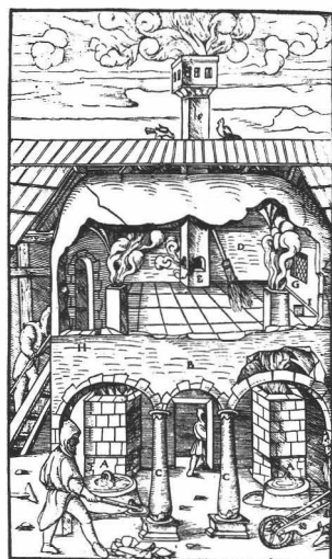
Abb. 5: Holzschnitt: Bleihütte mit Flugstaubkammer (AGA, Band 8: „De re metallica“, S. 513)
