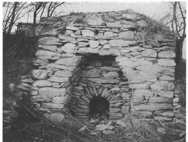
Einer von drei noch existierenden Kalkmeilern in Elsenreith. Er wurde 1995 freigelegt und soll zu Schau- und Lehrzwecken wieder in Betrieb genommen werden.
