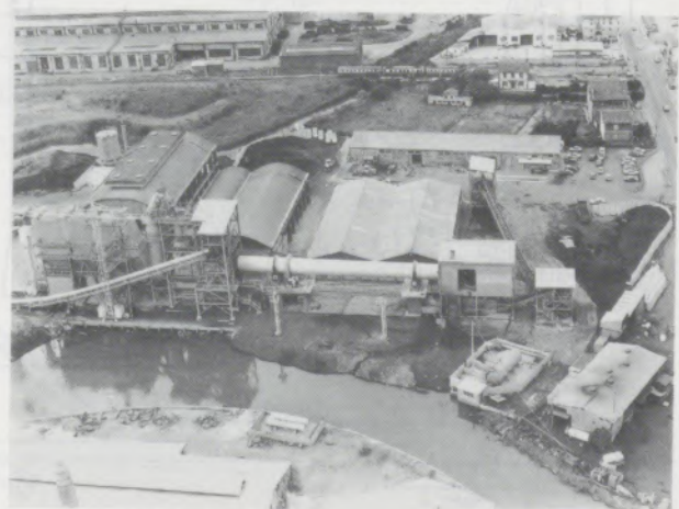
Abb. 3 Wälzanlage von Aser SA in Spanien (Bilbao)
