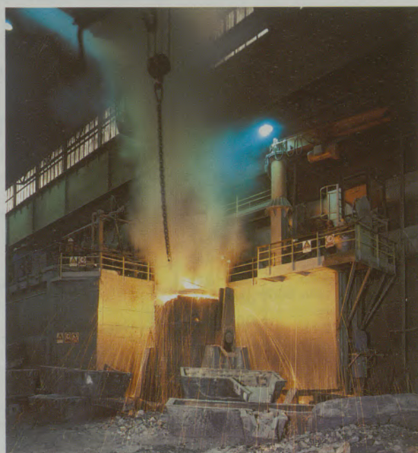
Abb./Fig. 2 Anlage während des Betriebes Plant during operation
