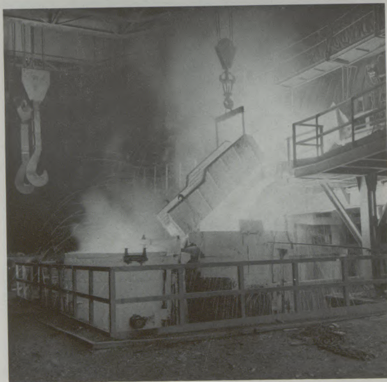
Abb. 4 / Fig. 4 Abstich in die zweite Pfanne Colata nella seconda secchia
