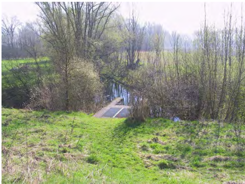
Abbildung 96: Dükereinleitung in die Schwarzaist (Abb. Mach 2:)
