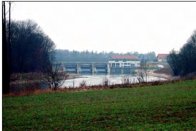
Abbildung 58: Stauanlage des Kraftwerkes Lambach (Fallhöhe 9,5 m,
