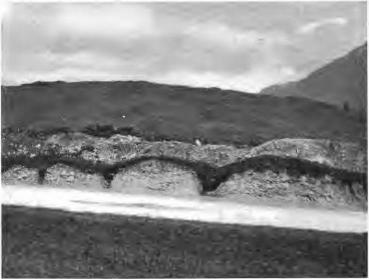
Abb. 7. Buckel von Hauptdolomit und Grundmoräne, getrennt durch Verwitterungssäcke, überlagert vom Aushub aus der Straße von Mittenwald nach dem Luttensee 1937. Seither mit Rasen abgeböscht.
