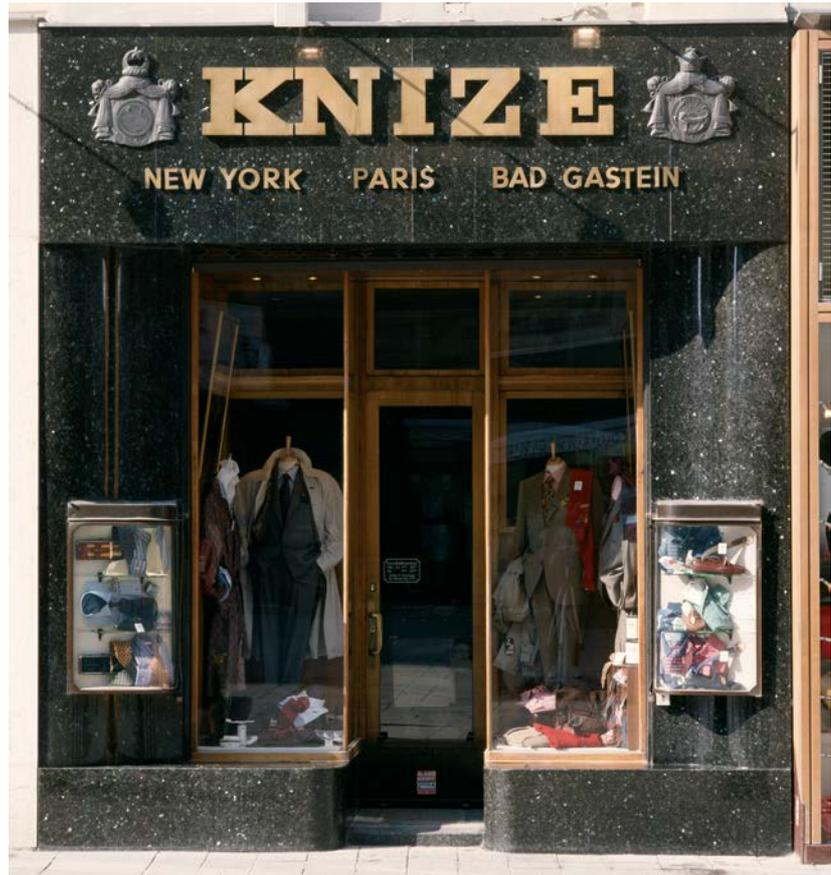
Abb. 35: Die Geschäftsfassade des Schneidersalons „Knize“ besteht aus dem Larvikit „Labrador Dunkel“ aus Norwegen.
