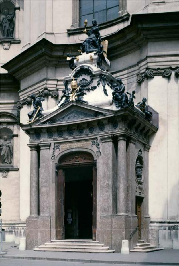
Abb. 31: Das Hauptportal der Peterskirche besteht aus einer Dolomitleukite aus Niederösterreich, die Stufen aus Leithakalk von Kaisersteinbruch.
