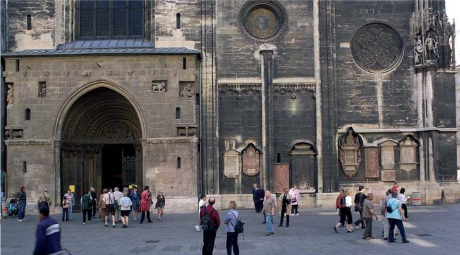
Abb. 43: Westfassade des Doms zu St. Stephan. Dieser wurde vorwiegend aus jungtertiären Leithakalken der Wiener Umgebung erbaut, Restaurierungsarbeiten werden meist mit Kalksandstein aus St. Margarethen (Burgenland) durchgeführt. In der Westfassade des Doms sind noch Teile aus den romanischen Bauperioden erhalten geblieben. Das Baumaterial ist vorwiegend Leithakalk von verschiedenen Steinbrüchen der Wiener Umgebung.
