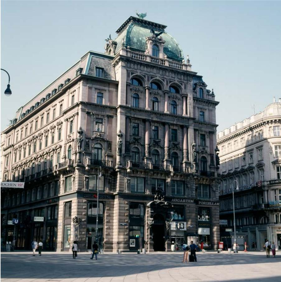
Abb. 39: Die massive Granit-Fassade des „Palais Equitable“ besteht aus „Maissauer Granit“, Sockel und Portal aus tschechischem Granodiorit, Säulen und Pilaster aus „Rotschwedischem Granit“
