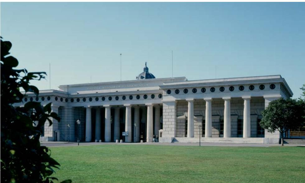
Abb. 4: Äußeres Burgtor. 1996 wurde das Äußere Burgtor mit heller Farbe gestrichen. Seither ist die Unterscheidung der unteren Säulentrommeln aus Wöllersdorfer Algenkalk und der oberen Trommeln aus St. Margarethener Kalksandstein etwas erschwert.
