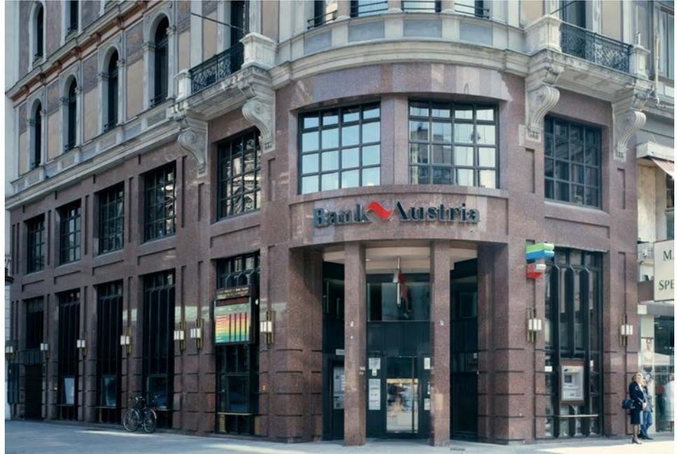
Abb. 41: Die Fassade der „Bank Austria“ am Stephansplatz besticht durch den intensiv roten Granit aus der Ukraine, tiefrot die Kalifeldspäte, we-niger auffallend die roten Granate in den Zwickeln.
