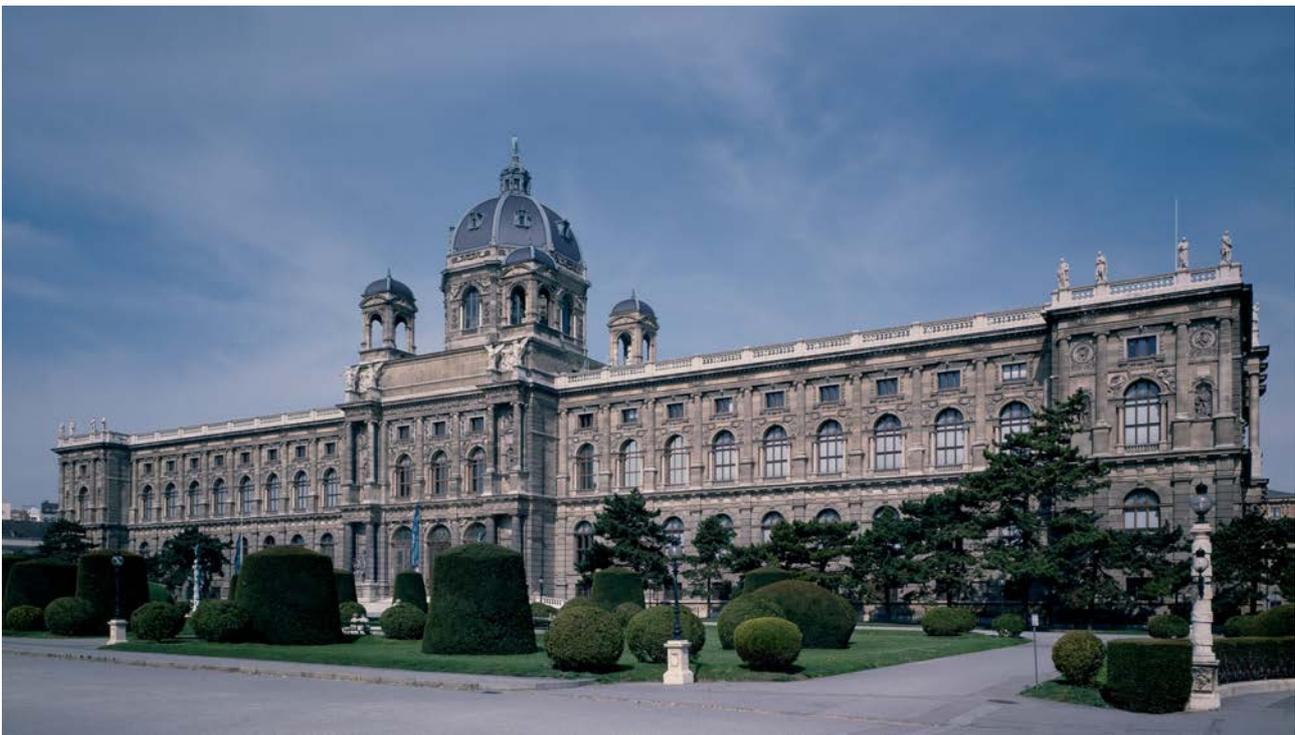
Abb. 2: Naturhistorisches Museum, Südostfassade. Das aufgehende Mauerwerk ist aus Kalksandstein verschiedener Herkunft, das Dach ist mit rotem Schiefer aus Le Mans, und grauem Schiefer von Carnavonshire gedeckt.
