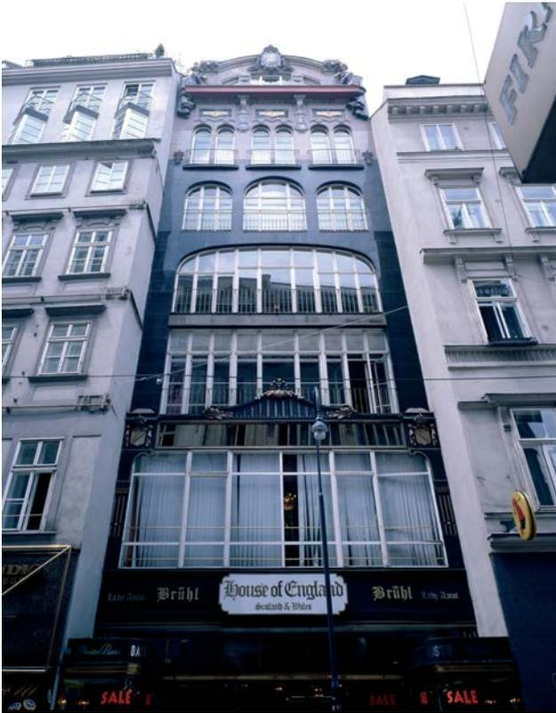
Abb. 28: Fassade des Hauses Kohlmarkt 2. Verkleidung: „Labrador Dunkel“, „Labrador Hell“ und „Rosengranit“.
